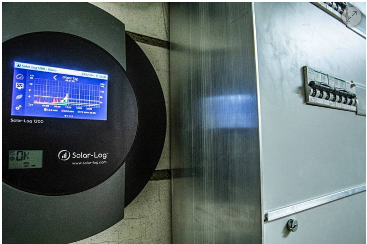
Der Solarlog ist das Herzstück des intelligenten Energiemanagements. Er ermöglicht unter anderem die Steuerung und Überwachung der Anlage via App aus der Ferne. Monika Flückiger
