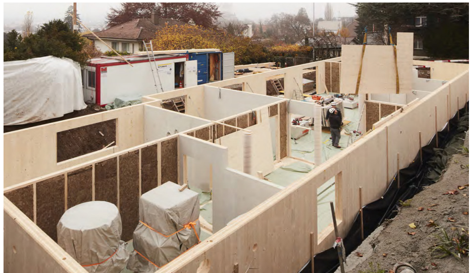
Der Keller entsteht aus Holzwänden.
