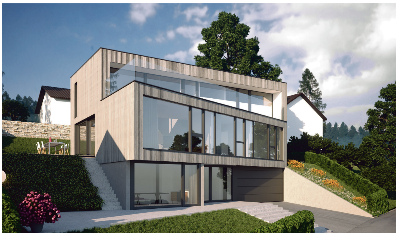
Grosse Glasflächen in Bodennähe müssen neu mit Sicherheitsglas umgesetzt werden – hier im Beispiel eines Einfamilienhauses in Evilard.
